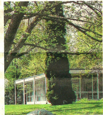
Die Gruga-Verwaltung scheut zu Recht vor einem Abriss des Pavillons zurück.
